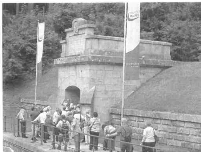
Bild: Kaiserbrunn Wasserleitungsmuseum
